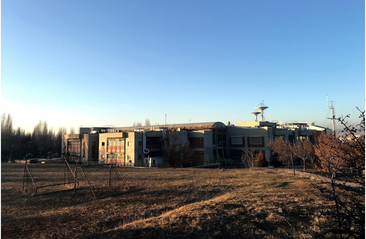
Şekil 2. TÜBİTAK Uzay Teknolojileri Araştırma Enstitüsü Dış Görünüş-2
