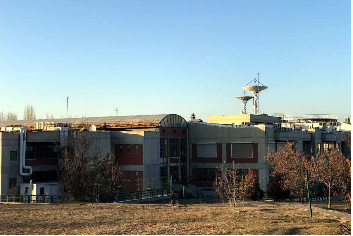
Şekil 3. TÜBİTAK Uzay Teknolojileri Araştırma Enstitüsü Dış Görünüş-3
